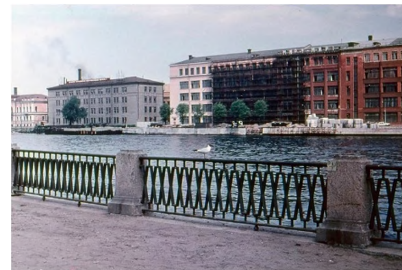
Рисунок 10 – Замена облицовки фасадов 131 и 132 корпусов. 1971–1972 годы (pastvu.com)
