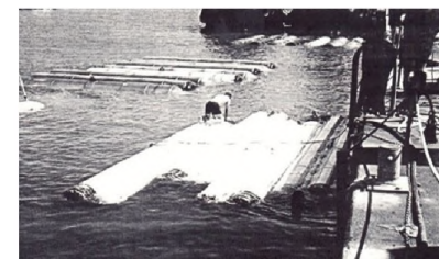
Рисунок 21 – Подготовка магнитных модулей трала-имитатора Mini Dyad на плаву у стенки
