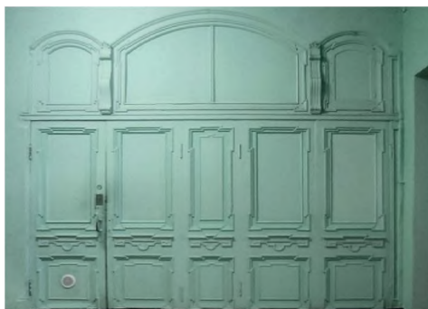
Рисунок 21 – Деревянные панели в вестибюле второго этажа
