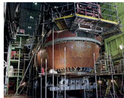
Рисунок 5 – Размещение и монтаж антенны миноискания в носовой части головного образца ПЛ пр. 677 на стапеле завода-строителя
