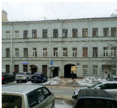
Доходный дом на 3-й линии В. О., 8 (арх. А. К. Бруни, реконструкция, 1874)
