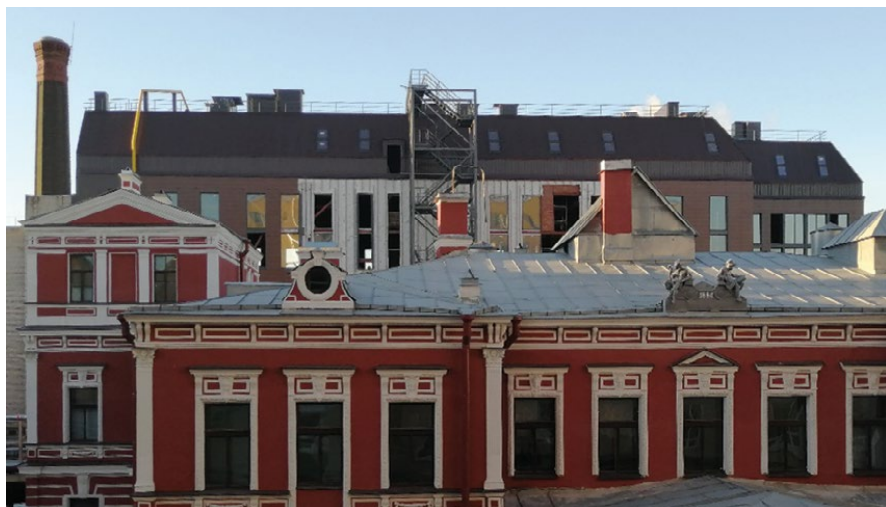
Рисунок 5 – Особняк и строящийся комплекс испытательных стендов и научных лабораторий (на заднем плане)
